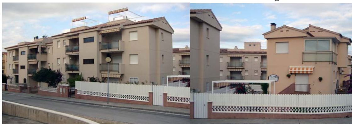
1988 · c/ Pàndols – Av. Oliveres · Torredembarra · Tarragona
